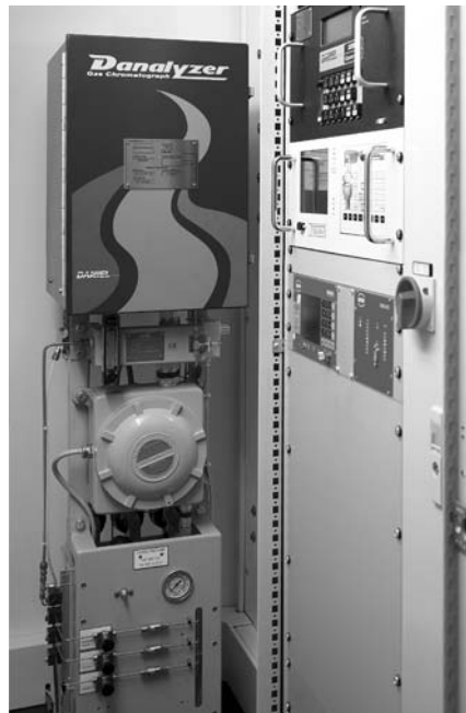
Mess- und Steuerraum mit PGC
